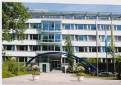
Im Rahmen der Sanierung wurde auch der Eingangsbereich neu angelegt.
